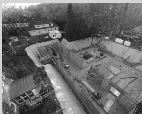
Bauarbeiten am unterirdischen Musikkomplex
