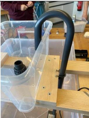
Die Klemmdurchführung wird in die kleine Box eingedreht. Dafür wird die Klemmdurchführung durch das gefräste Loch geführt und mit dem Gegenstück festgeschraubt (siehe **Abbildung 1, Nr 3**).
