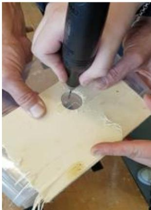
Für die Anbringung der PVC-U Klemmdurchführung als Teil des Siphonsystems muss eine Öffnung (Durchmesser 20 mm) in den Boden der kleinen Box gebohrt werden. Dafür wird eine Holzvorlage mit einem Forstnerbohrer angefertigt. Die Box wird auf den Kopf gestellt die Vorlage mittig aufgebracht und das Loch mittels Dremel ausgefräst.
