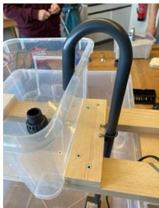
Das PVC-U Druckrohr 16x1,5 mm wird auf der Pumpe aufgebracht (siehe **Abbildung 1, Nr 2 und 5**), damit die Länge ermittelt werden kann. Das Rohr muss im Anschluss gebogen werden, sodass das freie, obere Ende in die Pflanzenbox hineinragt (Pflanzenbewässerung und Nährstoffversorgung).
